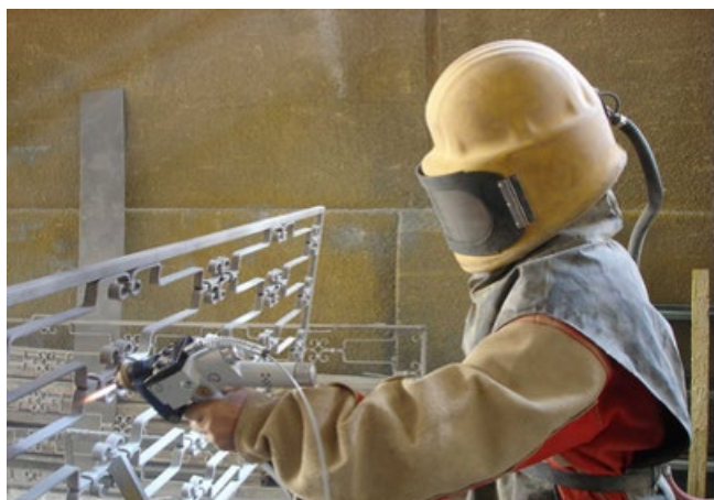
Foto 2 - Metalização à chama com zinco em portão
