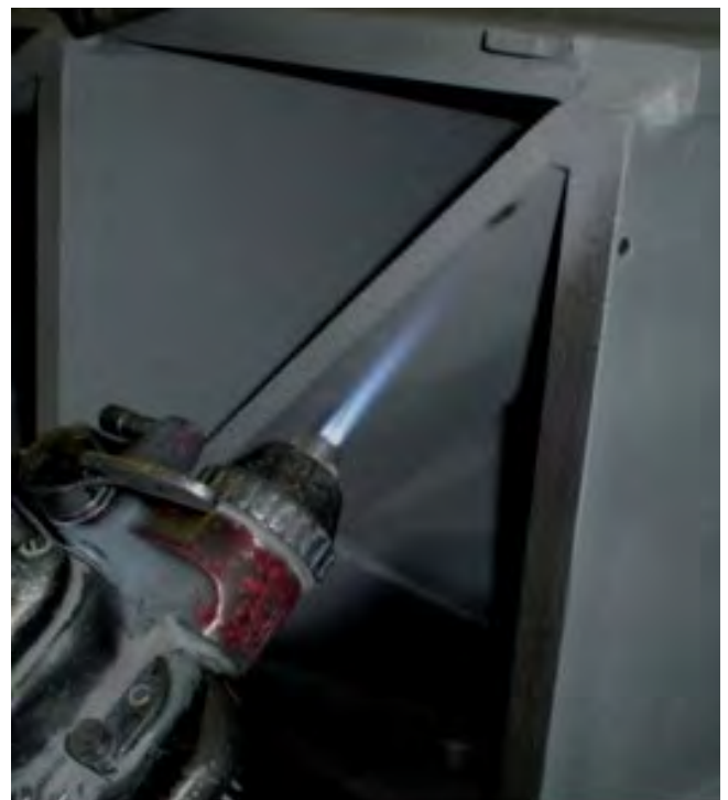
Foto 4 - Metalização a chama com deposição de zinco em estrutura de ponte
