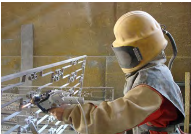
Foto 2 - Metalização à chama com zinco em portão
