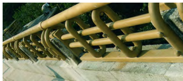
Foto 8 - Estrutura instalada [Ref. 10.o]
