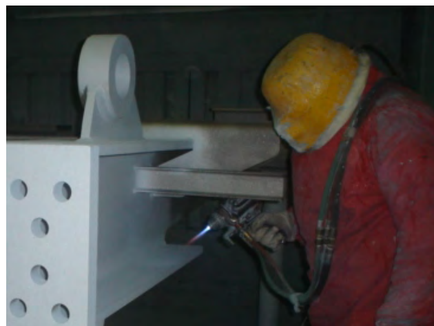
Foto 3 - Metalização de estrutura de nacela [Ref. 10.m]
