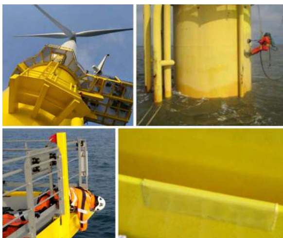
Figura 32 - Reparos pontuais de revestimento epóxi com manchões PIB em torres de energia eólica.
