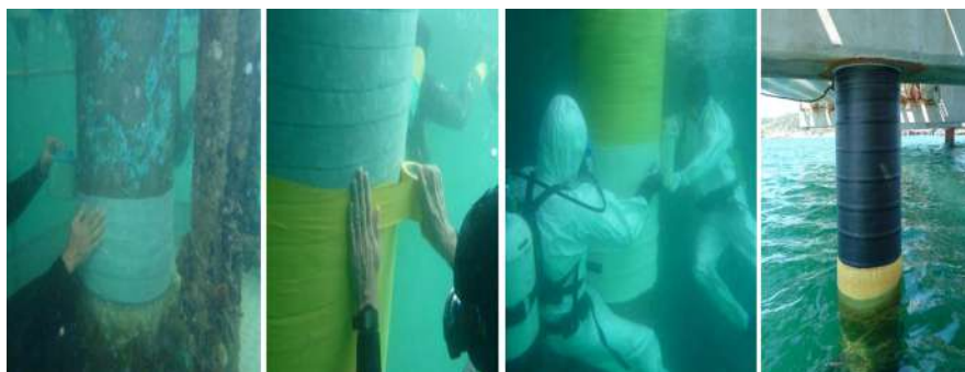
Figura 29 – Aplicações subaquáticas de revestimento à base de PIB e em zona de variação de maré, executadas por mergulhadores.
