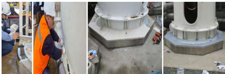
Figura 24. Aplicação de revestimentos à base de PIB em estruturas e tanques com bases de concreto.
