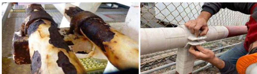
Figura 17. Revestimento de suportes de tubos.
