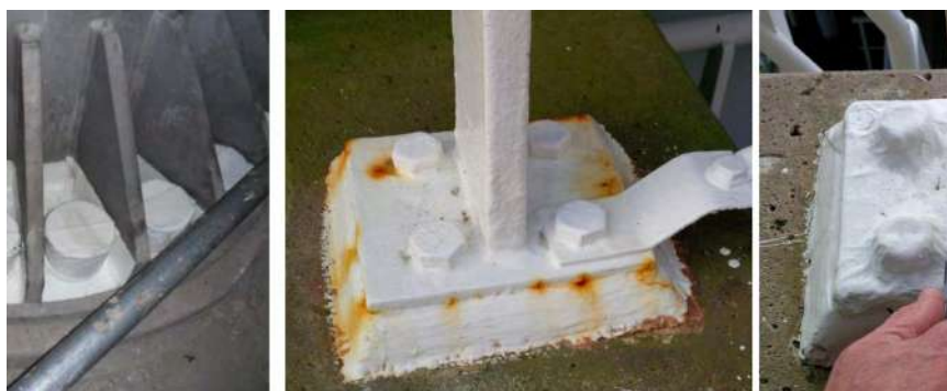
Figura 20. Revestimento de estruturas aparafusadas.
