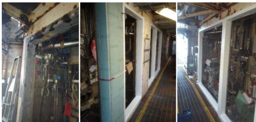
Figura 22. Aplicação de revestimentos à base de PIB em quinas de estruturas de plataformas de petróleo.
