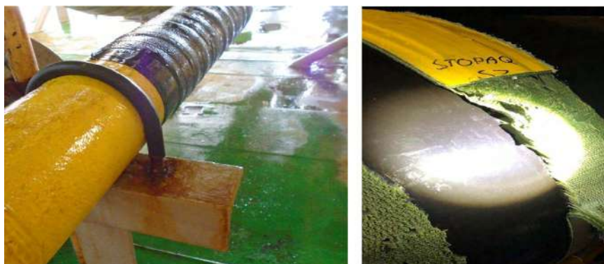
Figura 28. Aplicação de revestimentos à base de PIB em linhas com condensação de umidade. Checagem da aderência do composto PIB sobre a superfície de uma linha de condensado.
