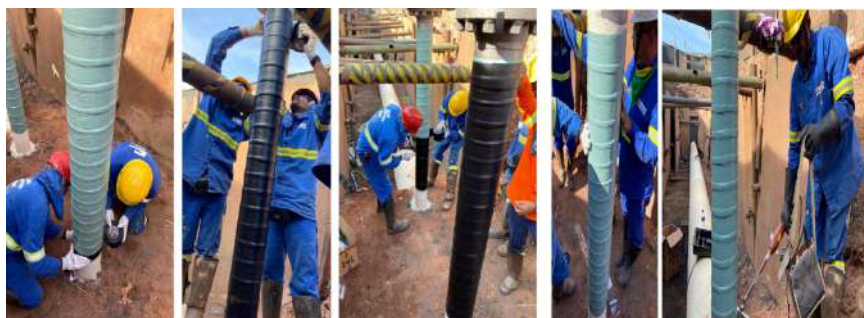
Figura 26. Afloramentos de linhas (transições solo/terra). Aplicação com a NTS - Nova Transportadora do Sudeste S/A, em 2022.
