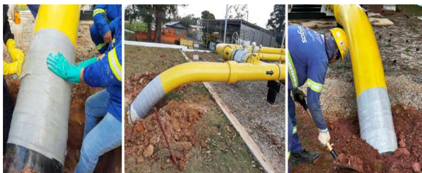
Figura 27. Afloramentos de linhas (transições solo/terra). Aplicação com a Comgás, em 2023.
