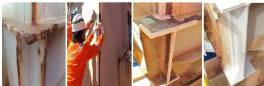
Figura 21. Aplicação de revestimentos à base de PIB na manutenção de quinas de estruturas, e arestas de estruturas, onde houve corrosão precoce.
