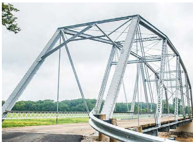
Figura 4: Ponte construída com aço galvanizado.
