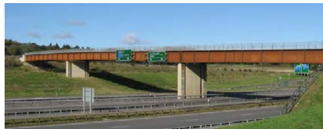
Figura 2: Ponte de aço patinável.
