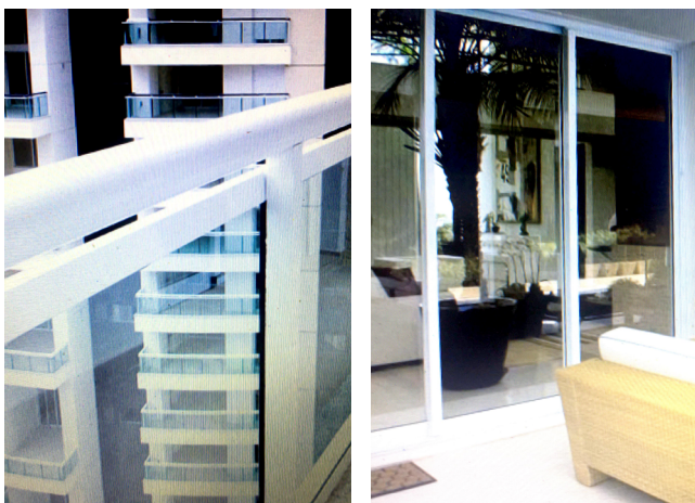
Guarda-corpo em sacadas e esquadrias montadas
