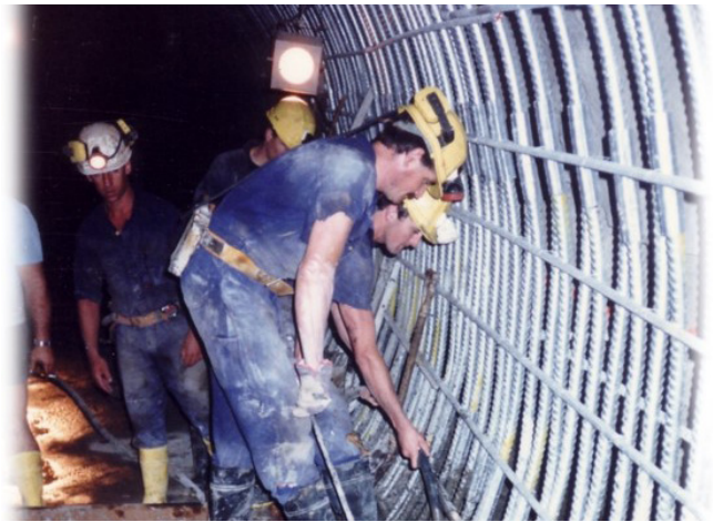
Concretando o forro do túnel
