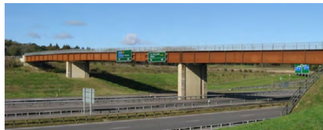
Figura 2: Ponte de aço patinável.
