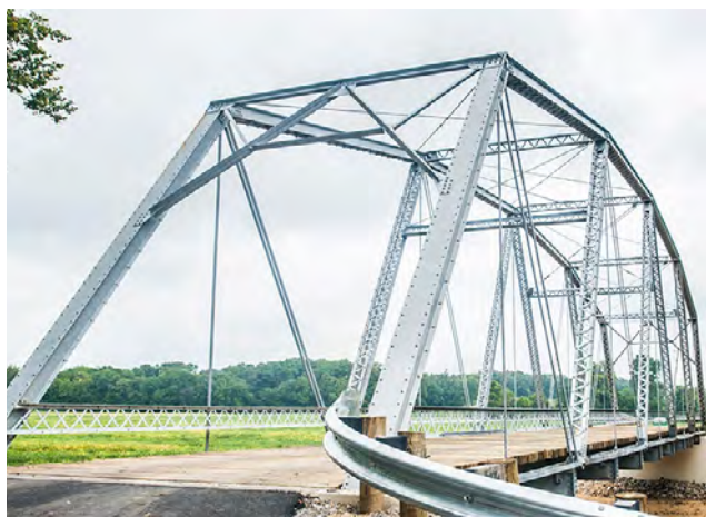
Figura 4: Ponte construída com aço galvanizado.
