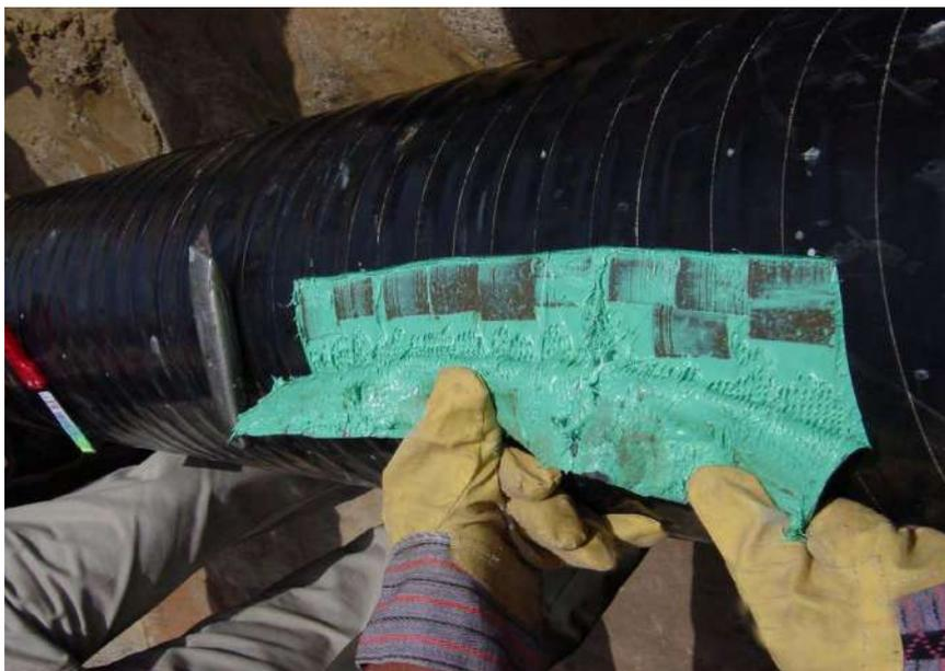
Figura 15 - Os revestimentos PIB aderem e cobrem toda a superfície do aço em escala molecular sem o uso de primer ou adesivo, enquanto outros tipos de revestimentos, como os que utilizam epóxios como camada primária, necessitam de um perfil de ancoragem para aderir mecanicamente à superfície do aço.
