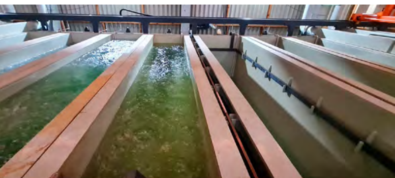
Tanques com sistema de agitação do banho
