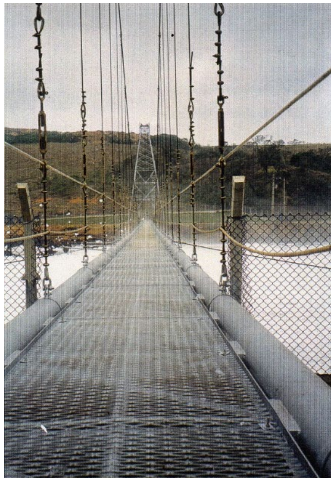
Foto 3 - Ponte para abatimento de espuma ácida no Rio Pirapora do Bom Jesus em Santana do Parnaíba, metalizada com zinco
