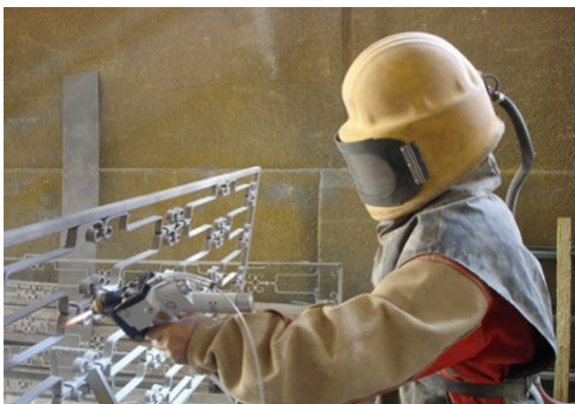
Foto 2 - Metalização à chama com zinco em portão
